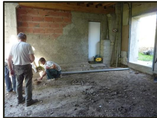
Afin de permettre aux eaux usées de s'écouler, un tuyau PVC est disposé sous la future dalle
