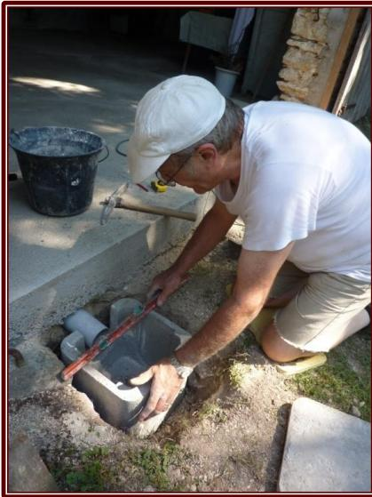
Après séchage de la dalle, à la sortie du tuyau PVC, un regard est encastré.
