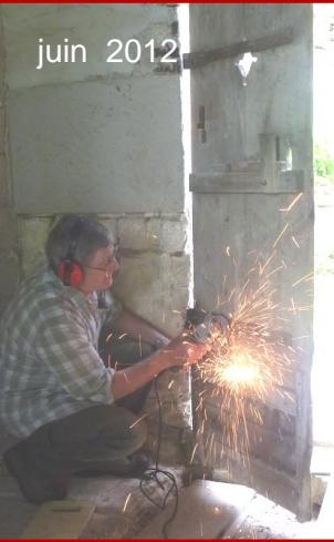
← Après séchage complet du linteau, l'ancienne porte est déposée et les linteaux en bois sciés →
