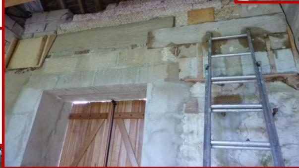
← La dégradation avancée du mur nord oblige une consolidation coffrée jusqu'en haut !
