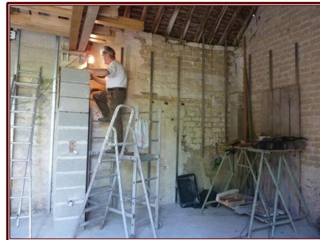
Le béton est versé autour du ferrailage sans oublier le câblage électrique.
